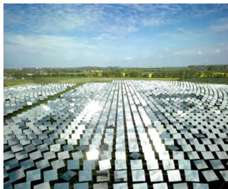
Blick vom Solarturm Jülich
